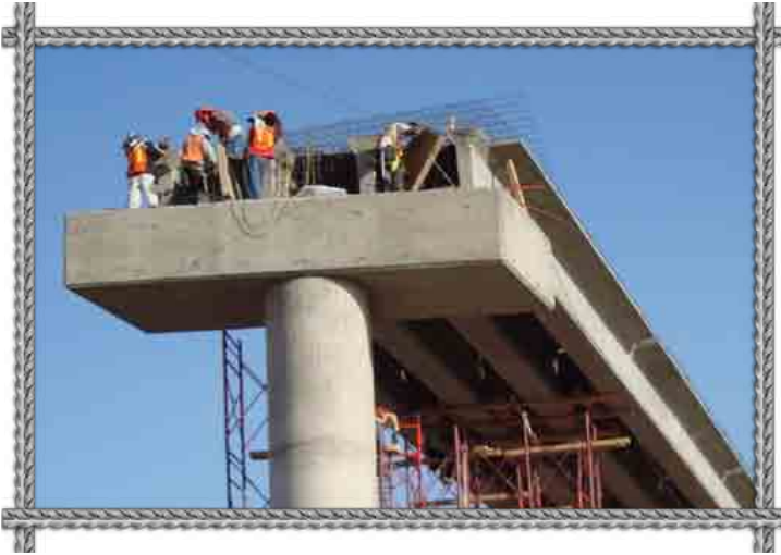
Distribuidor vial-Hermosillo Sonora
