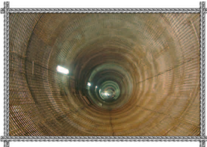
Túnel Río de la Compañía-Ciudad de México
