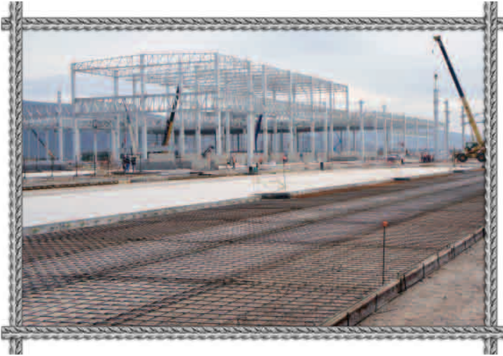
Nave industrial-Salvatierra, Gto.
